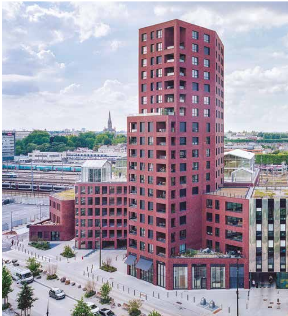
BUREAUX, PARKING PUBLIC ET LOGEMENT COLLECTIF - NANTES 44
